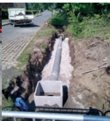
Remplacement de canalisation eaux pluviales rue d'Anizy à Chivy les Etouvelles
