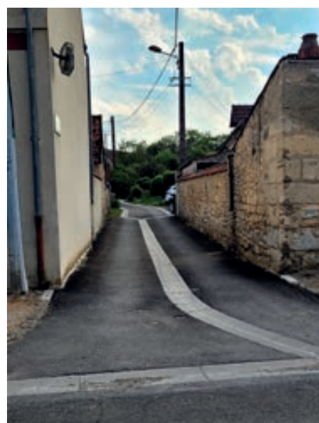
Parfondrou, réfection rue du Faubourg
