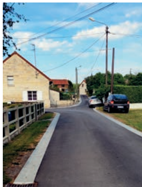
Parfondrou, réfection rue du Faubourg
