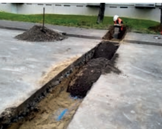
Remplacement de la canalisation eau potable avenue de l'Europe à Laon
