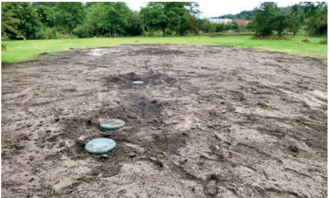
Tranchées d'épandage après remise en état
